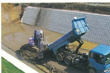
国道180号改良工事
