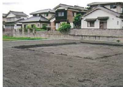
宅地造成工事
