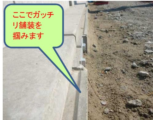
国道431号(大篠津和田工区)歩道設置工事で施工中の防草型歩車道境界ブロック
