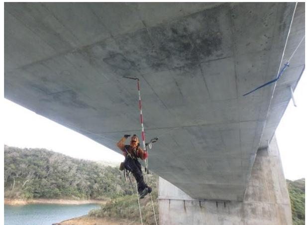
図 1-5 ロープアクセスによる点検状況
