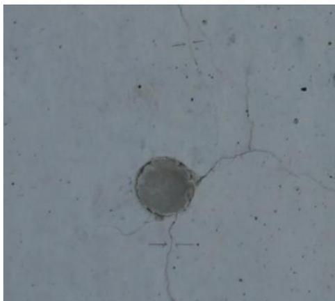
図 3-3 コンクリート表面のひびわれ
