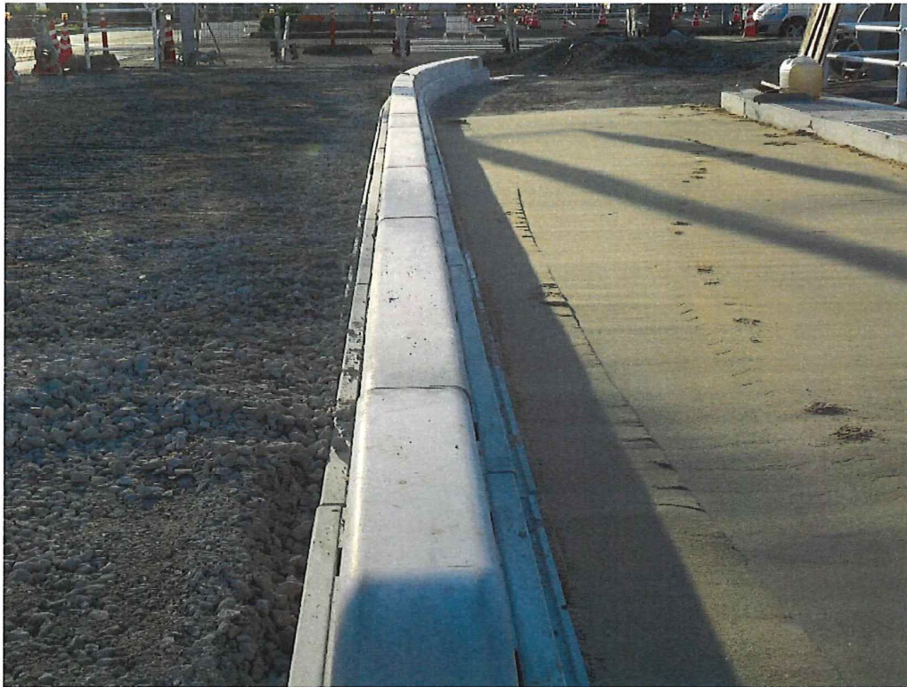
鳥取県米子市内 防草型歩車道境界ブロック施工状況
